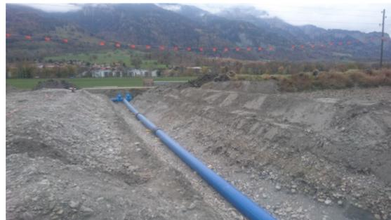
Im Bereich der Zuleitung von der Grundwasserpumpstation ist der Boden sehr flachgründig. Das Rohr wird im kiesigen Untergrund verlegt.
