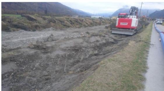
Der Oberboden aus dem alten Bewässerungskanal wurde bereits abgetragen und auf dem Humusdepot zwischengelagert. Im zweiten Schritt wird der BC-Horizont abgetragen und der Graben für das Verlegen der Rohre vorbereitet
